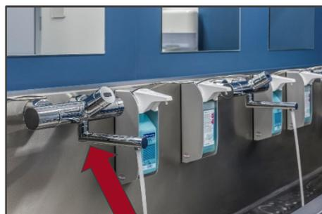
Berührungslose und vernetzte Armaturen spülen gleichzeitig, um eine turbulente Strömung zu erzielen
